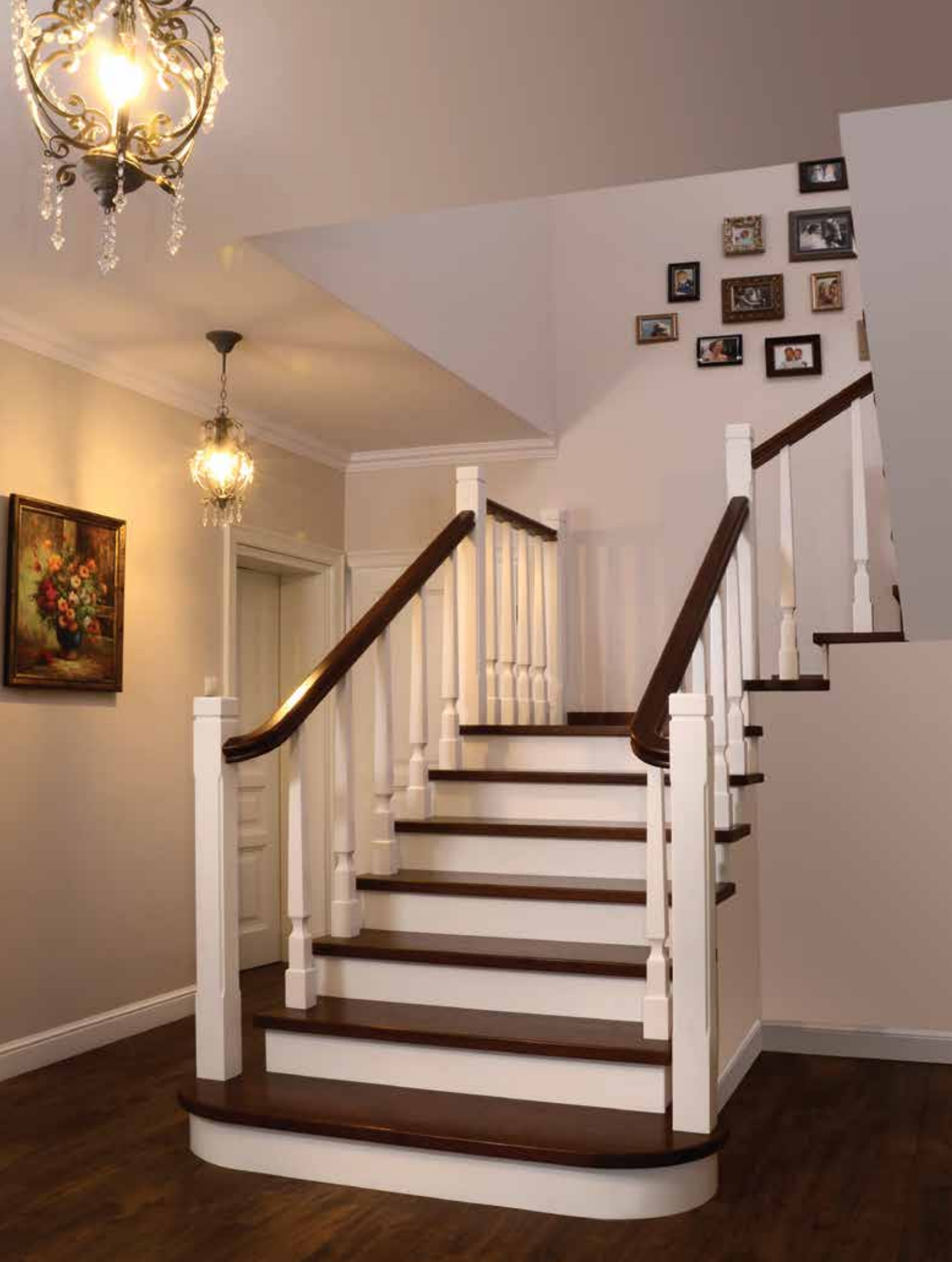
P155 Schody na beton | drewno: dąb bejcowany | balustrada: drewniana Betontreppen | Holz: gebeizte Eiche | Geländer: Holz
