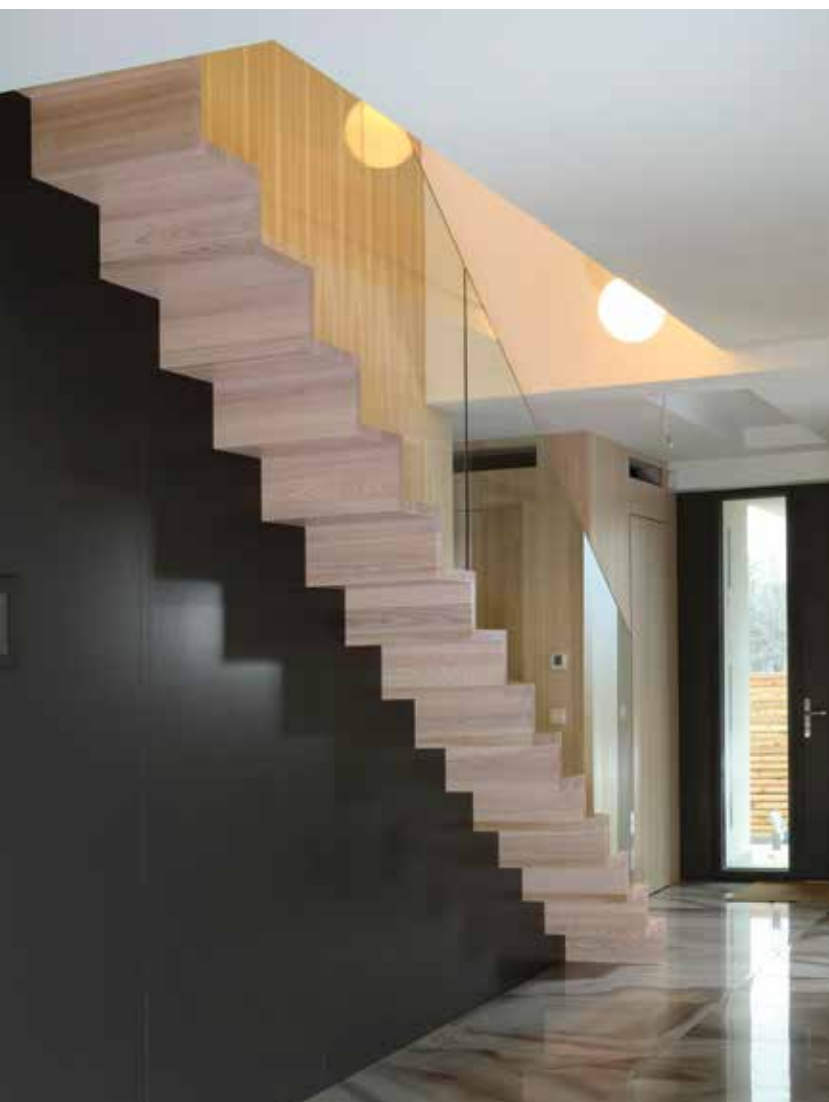
P184 Schody dywanowe | drewno: jesion | balustrada: szkło Faltwerktreppe | Konstruktion: Metall | Holz: Esche | Geländer: Glas
