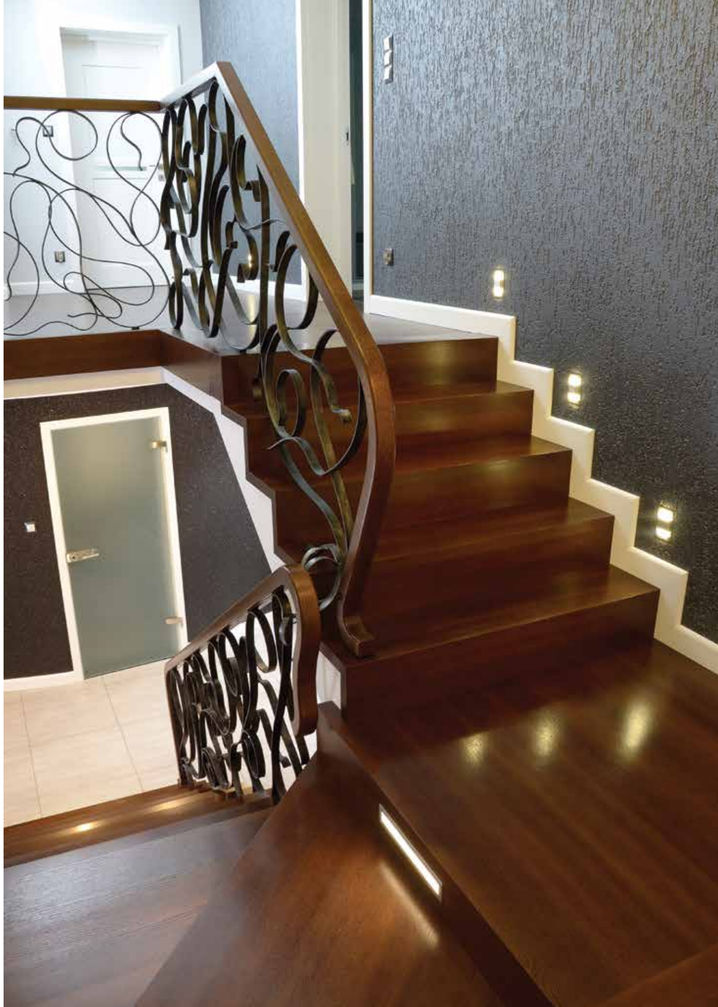
P171 Schody na beton | drewno: dąb bejcowany | balustrada: kuta Betontreppen | Holz: gebeizte Eiche | Geländer: Kunstschmiedeeisen
