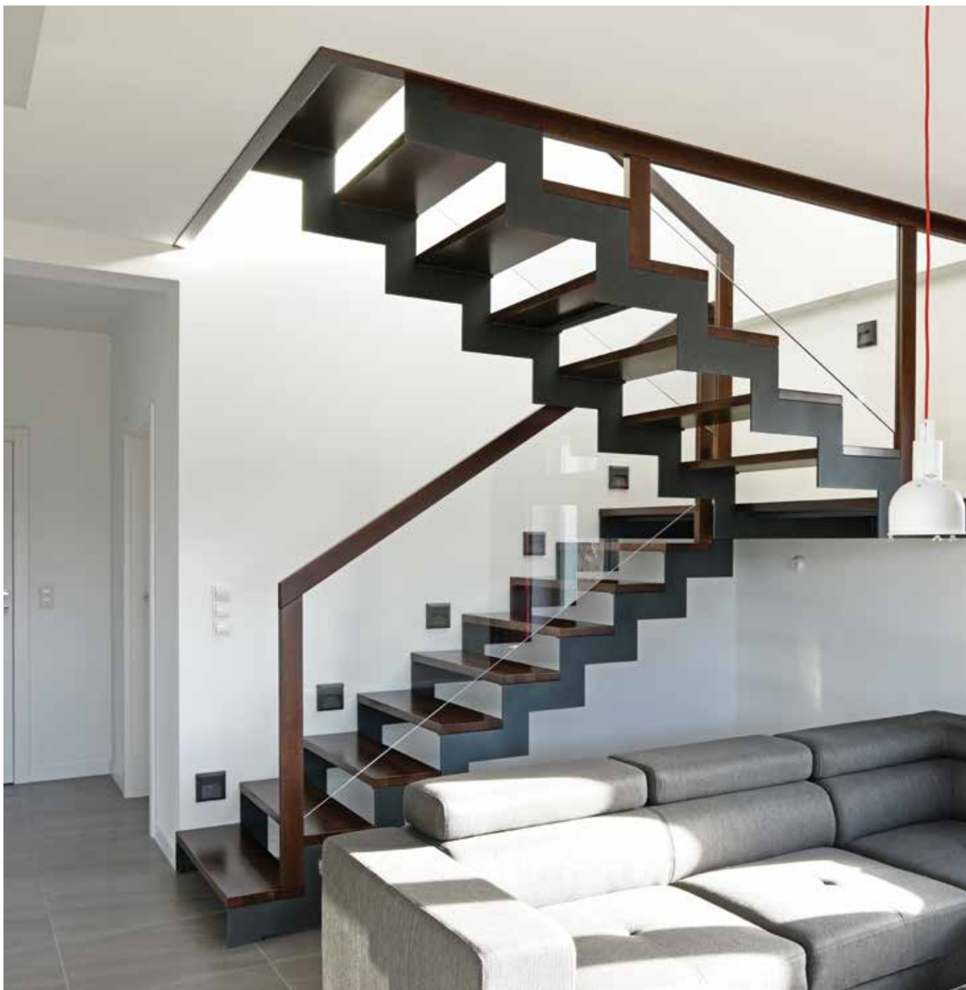
P185 Schody na konstrukcji metalowej | drewno:jesion bejcowany | balustrada: szkło + drewno Stahltruppe | Holz: gebeizte Esche | Geländer: Glas + Holz
