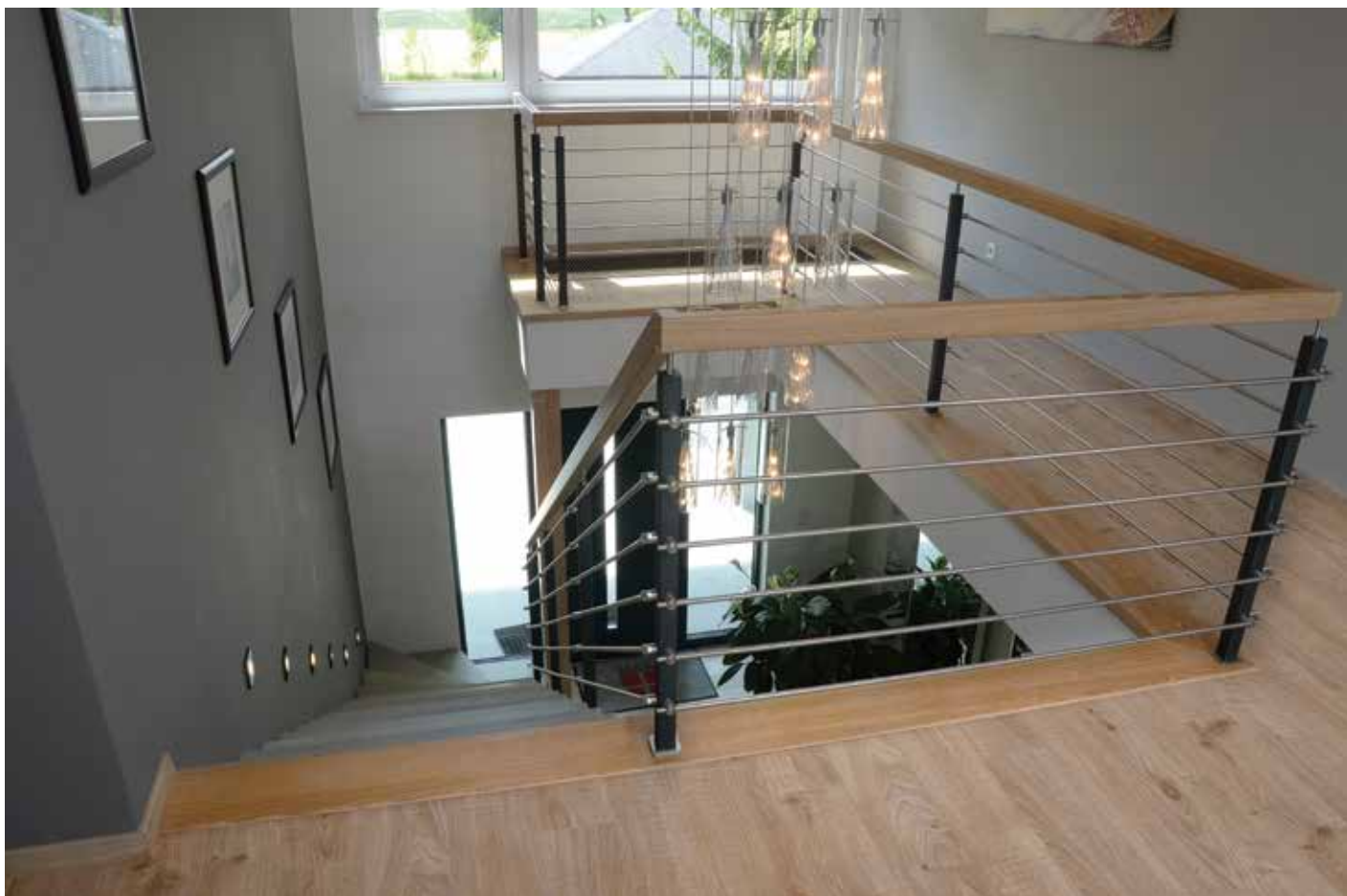
172 Schody na konstrukcji metalowej | drewno: dąb + kwarcyt | balustrada: stal Stahltrappe | Holz: Eiche + Quarzit | Geländer: Stahl
