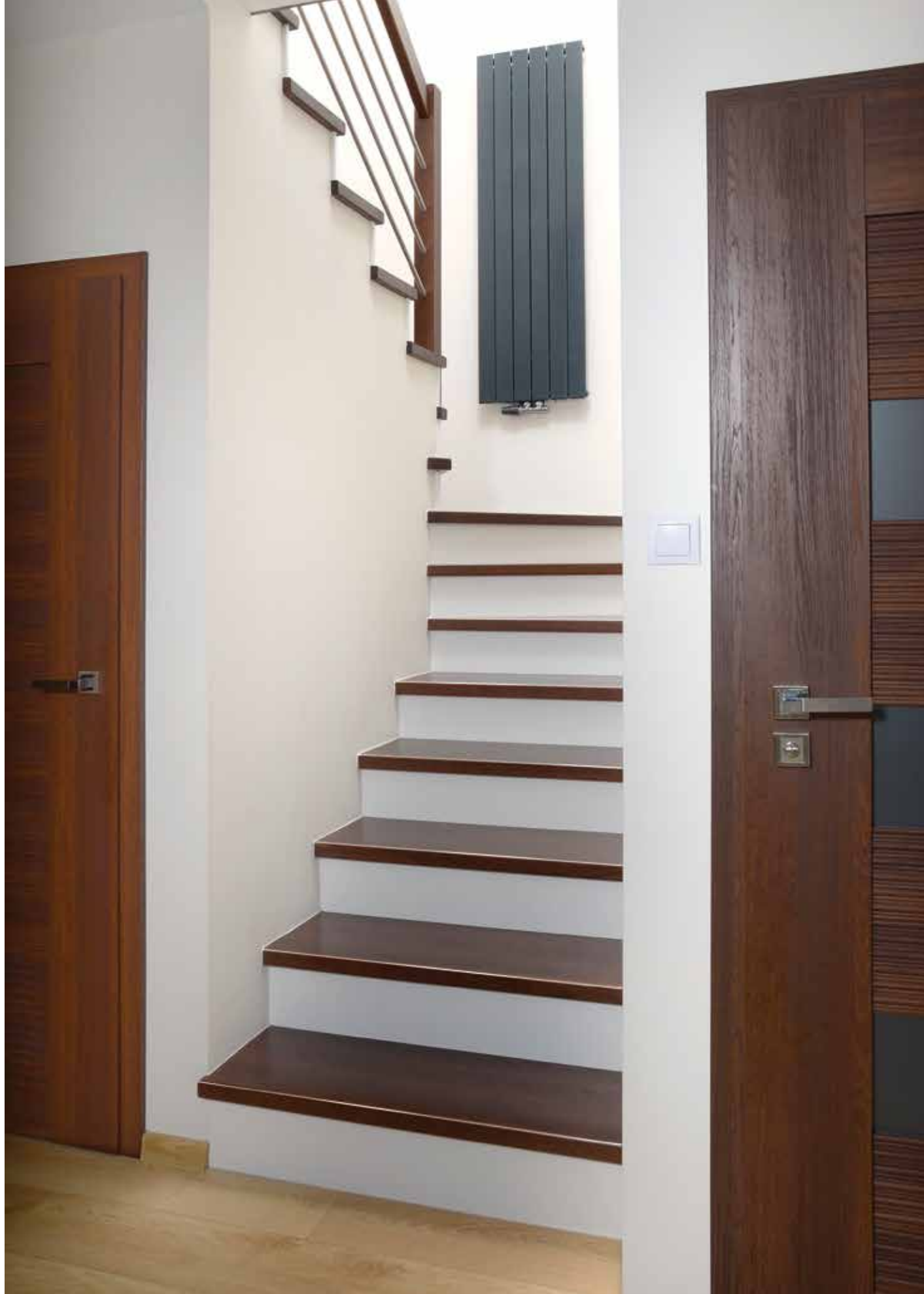
P168 Schody na beton | drewno: jesion bejcowany | balustrada: drewniana Betontreppen | Holz: gebeizte Esche | Geländer: Holz
