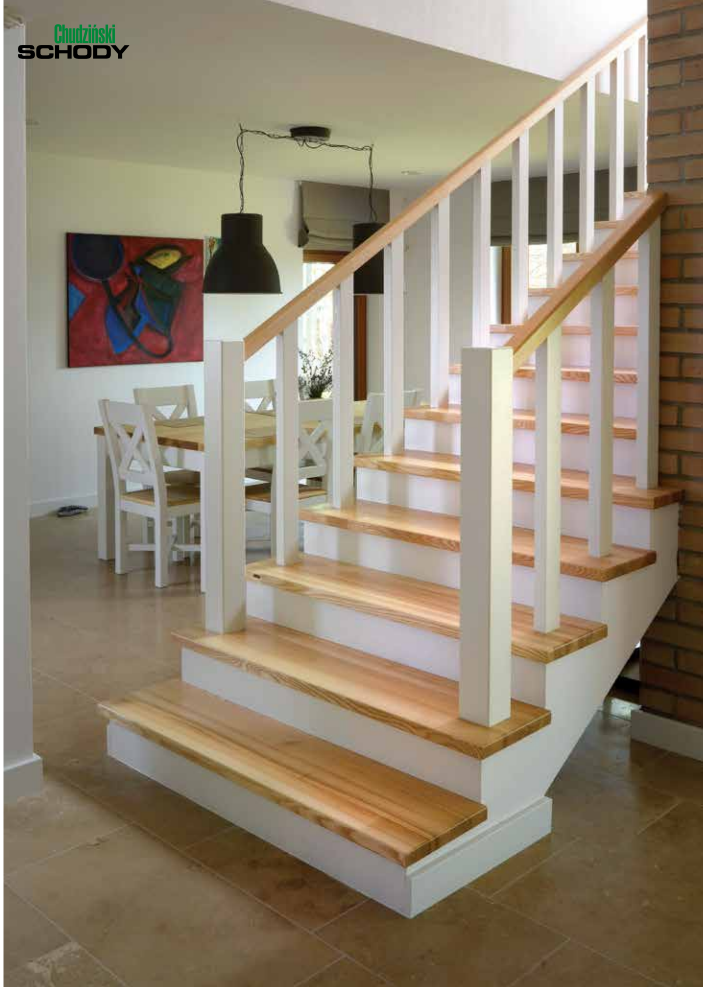
P173 Schody na beton | drewno: jesion | balustrada: drewniana Betontreppen | Holz: gebeizte Esche | Geländer: Holz
