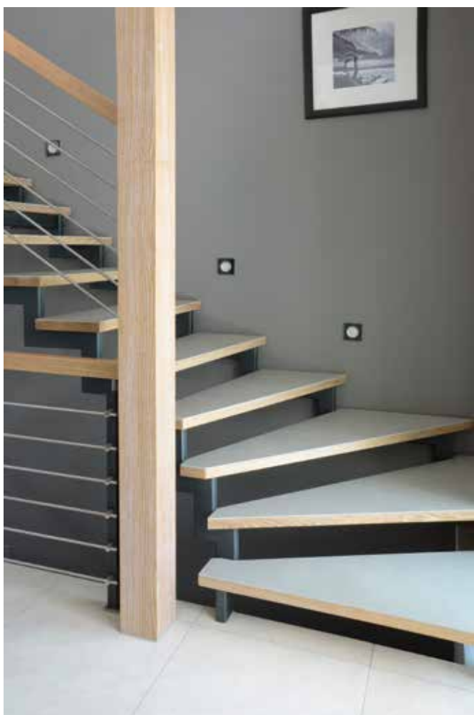
172 Schody na konstrukcji metalowej | drewno: dąb + kwarcyt | balustrada: stal Stahltrappe | Holz: Eiche + Quarzit | Geländer: Stahl
