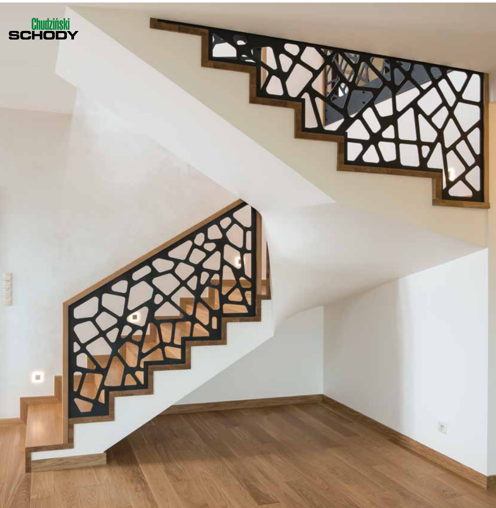
P211 Schody dywanowe na beton | drewno: dąb | balustrada: laser Betontreppen | Holz: Eiche | Geländer: Laser
