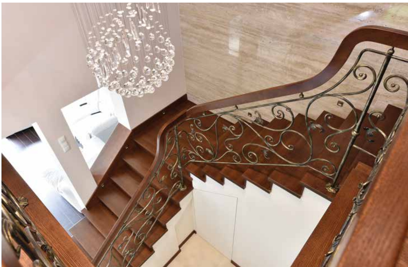
P195 Schody na beton | drewno: dąb bejcowany | balustrada: kuta + drewno Betontreppen | Holz: gebeizte Eiche | Geländer: Kunstschmiedeeisen + Holz
