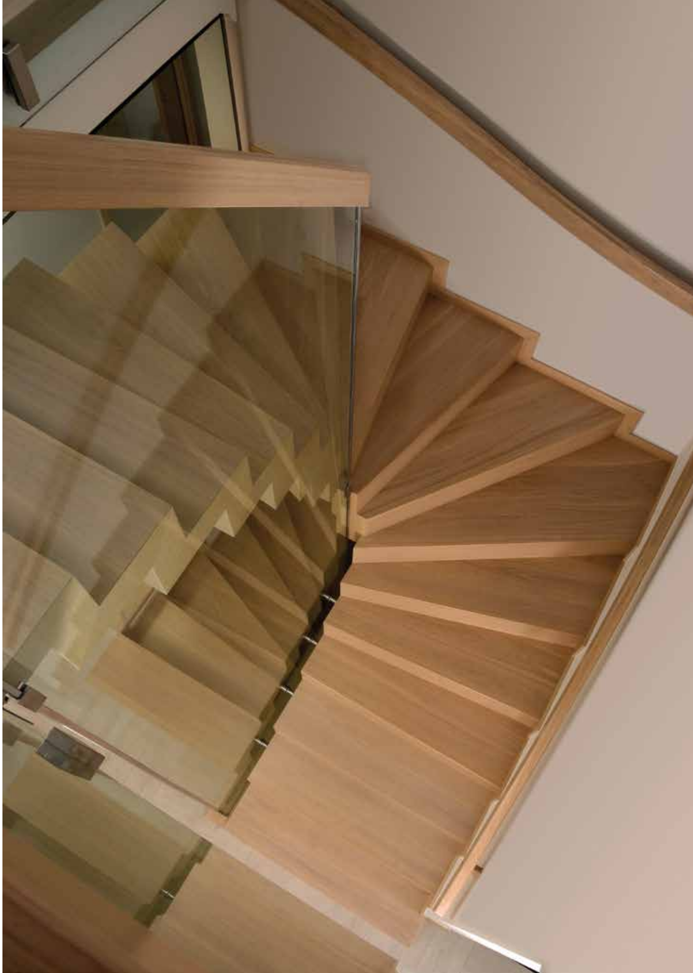
P151 Schody dywanowe | drewno: jesion | balustrada: szkło +drewno Faltwerktreppe | Konstruktion: Metall | Holz: Esche | Geländer: Glas + Holz
