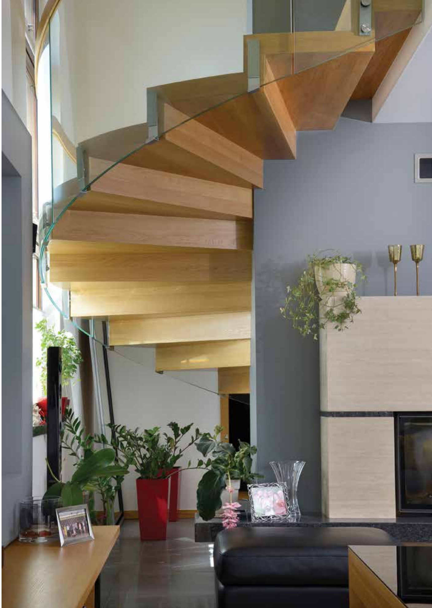
P167 Schody dywanowe | drewno: dąb | balustrada: szkło + drewno Faltwerktreppe | Konstruktion: Metall | Holz: Eiche | Geländer: Glas + Holz
