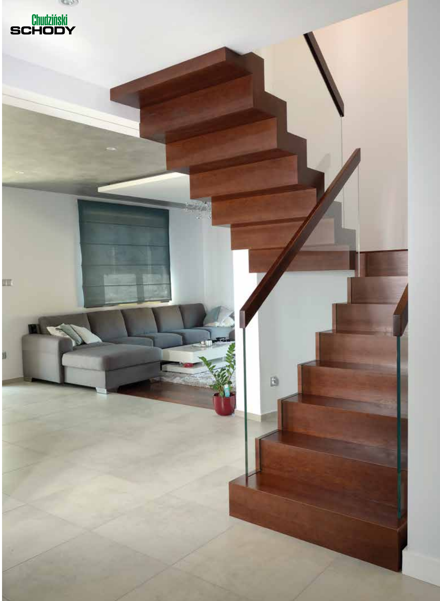
P177 Schody dywanowe | drewno: jesion bejcowany | balustrada: szkło +drewno Faltwerktreppe | Konstruktion: Metall | Holz: gebeizte Esche | Geländer: Glas + Holz
