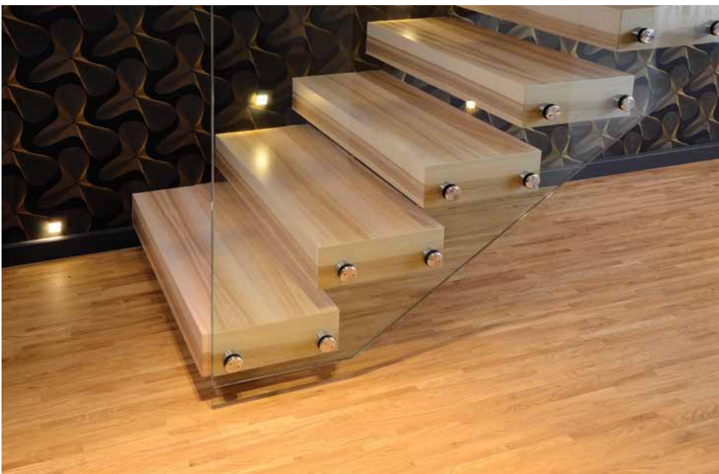
P150 Schody wspornikowe | drewno: jesion | balustrada: szkło + drewno Bolzentreppen Selbsttragend | Konstruktion: Metall | Holz: Esche | Geländer: Glas + Holz
