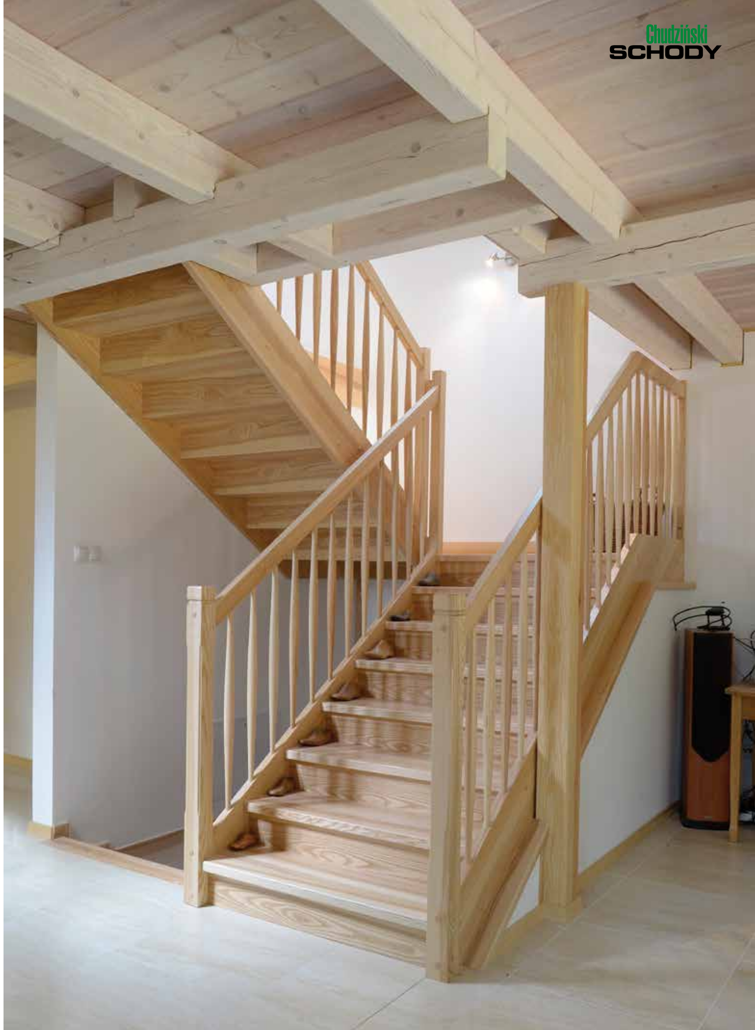
P161 Schody polickowe | drewno: jesion | balustrada: drewniana Wangentreppe | Konstruktion: Holz | Holz: Esche | Geländer: Holz
