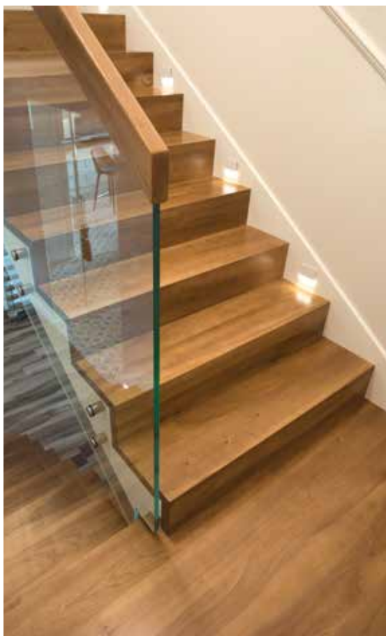
P204 Schody dywanowe na beton | drewno: wiąz bejcowany | balustrada: szkło + drewno Betontreppen | Holz: gebeizte Ulme | Geländer: Glas + Holz
