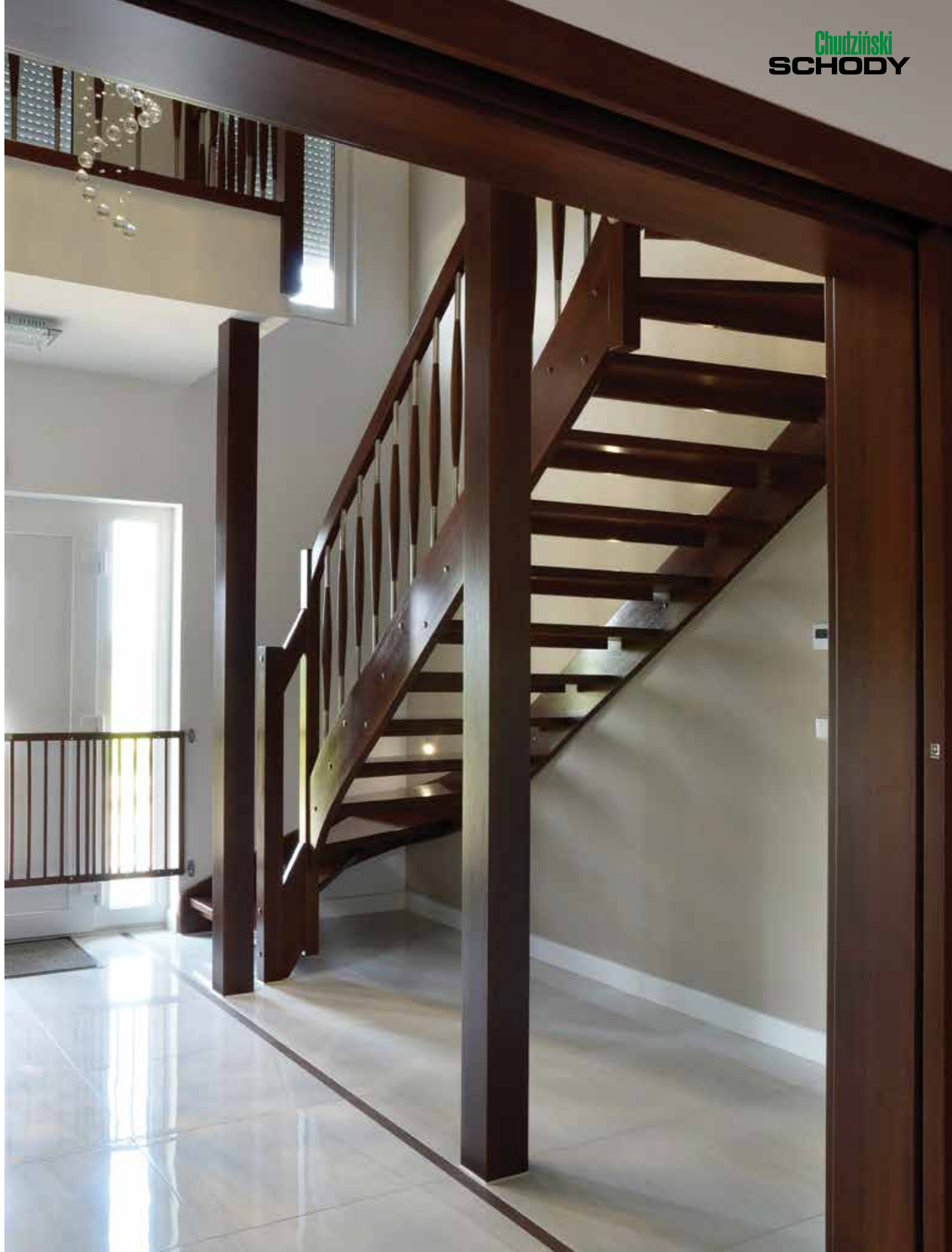
P169 Schody policzkowe | drewno: dąb bejcowany | balustrada: drewniana Wagentreppe | Konstruktion: Holz | Holz: gebeizte Eiche | Geländer: Holz
